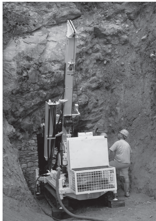
Fig. 2 - Carotiere posizionato all'imbocco della “Cava bassa”, la galleria scavata alla base della parete della Pesciara. Si noti il contatto laterale tra le rocce sedimentarie stratificate (a sinistra) e la breccia vulcanica (a destra).
