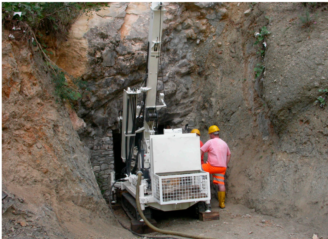
Pesciara: carotaggio continuo eseguito nel 2011 in corrispondenza della galleria inferiore dove c'è il contatto tra calcari dell'Eocene e rocce vulcanoclastiche
