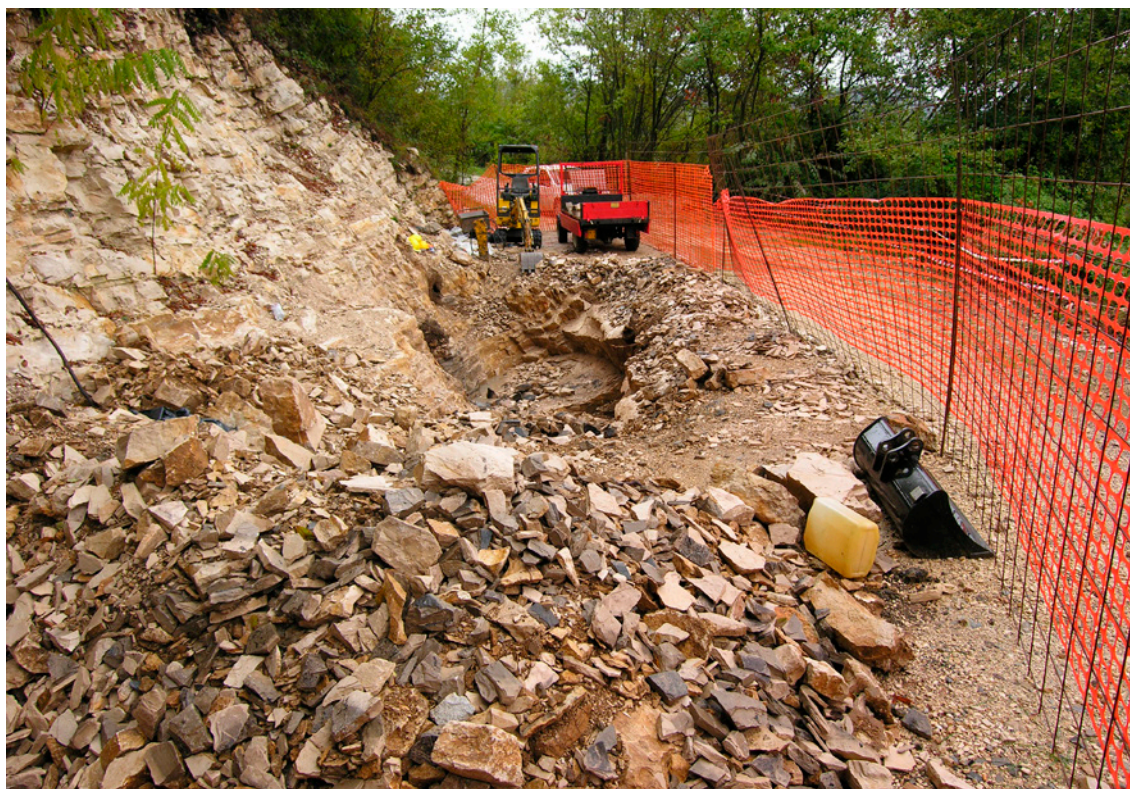
Monte Postale: gli scavi aperti nel 2008 lungo la strada che conduce alla Pesciara
