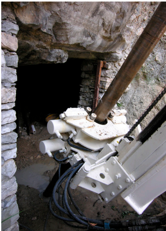
Pesciara: carotaggio continuo inclinato eseguito nel 2011 in prossimità dell'ingresso di una galleria scavata nell'800 e, a destra, sezione stratigrafica schematica.
