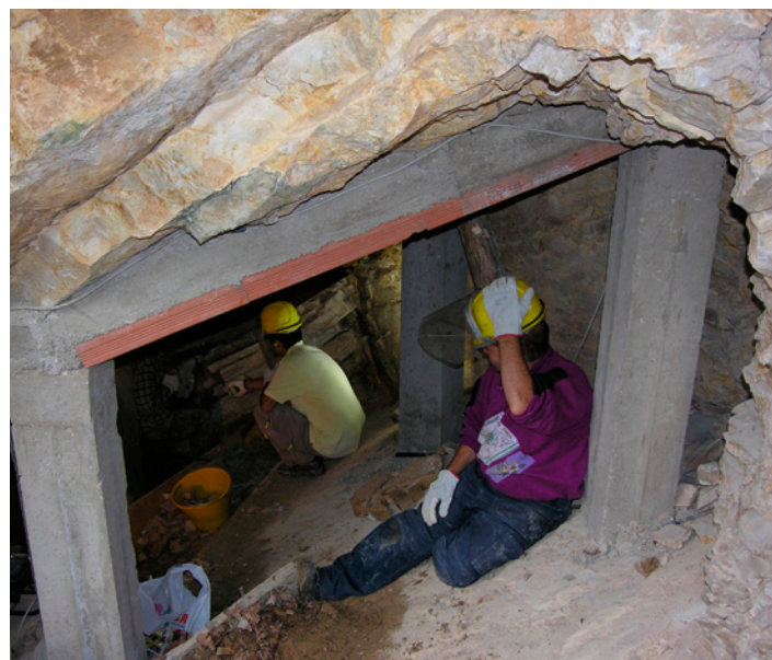
Pesciara, scavo in galleria
